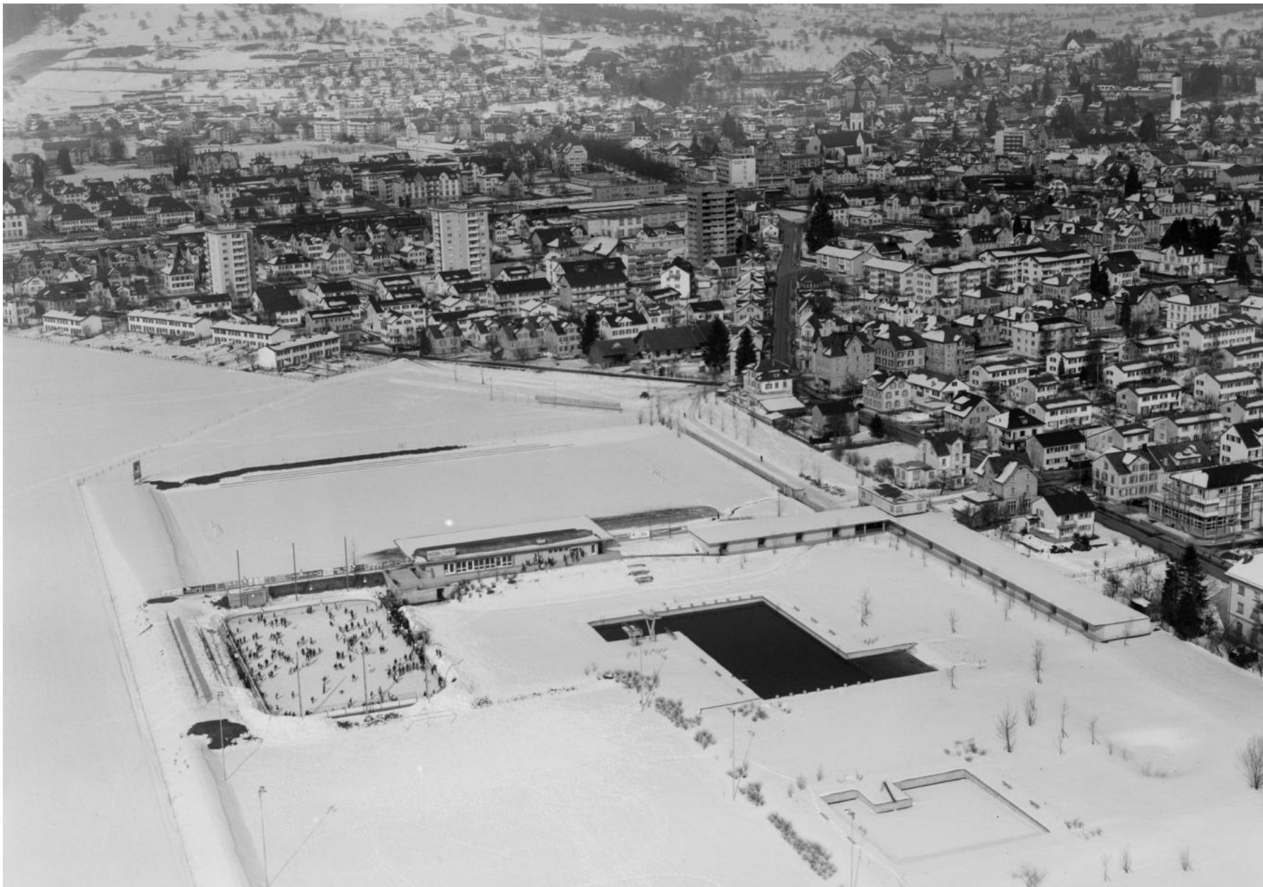
8. März 1965; Überdachung Eisbahn 1984
